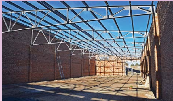
Рисунок 5 – Будівництво центрального складу соломи
